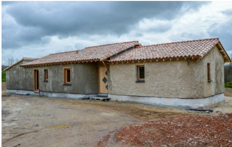
© Biofib'Isolation - La construction de cette maison en bois et béton de chanvre a duré 10 mois et coûté 1500 €/m²
